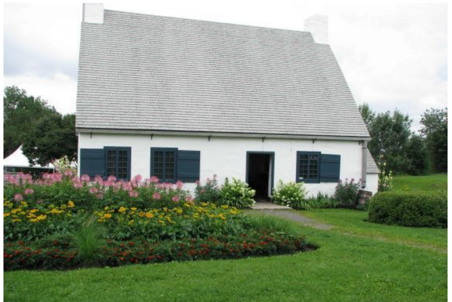
La maison Girardin, construite vers 1800, est située au 600 de l'avenue Royale, à Beauport. La Société d'art et d'histoire de Beauport y produit des animations. Son emplacement fut d'abord le site de deux constructions en bois, la première en colombages érigée vers le début du 18 ième siècle, et la seconde, pièces sur pièces, vers 1760.
